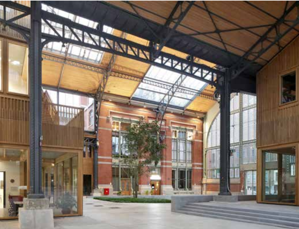
Bij de entree van het gebouw is de wisselwerking tussen bestaand en nieuw goed zichtbaar.
